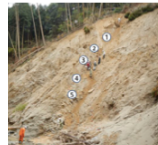
図8 原位置簡易強度試験の調査箇所
