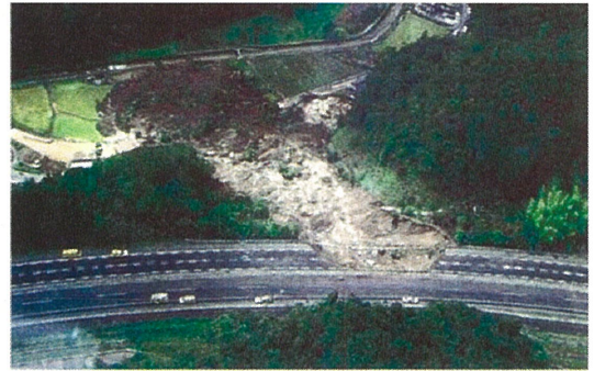
写真-1 豪雨による盛土の大規模崩壊 (山陽自動車道, 2005年9月)
